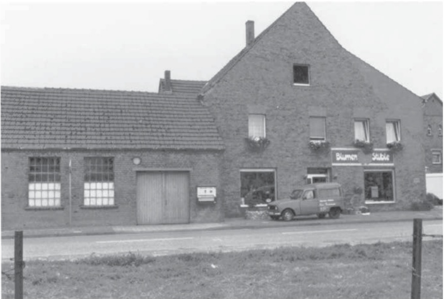
Ehemalige Schmiede Hußmann
