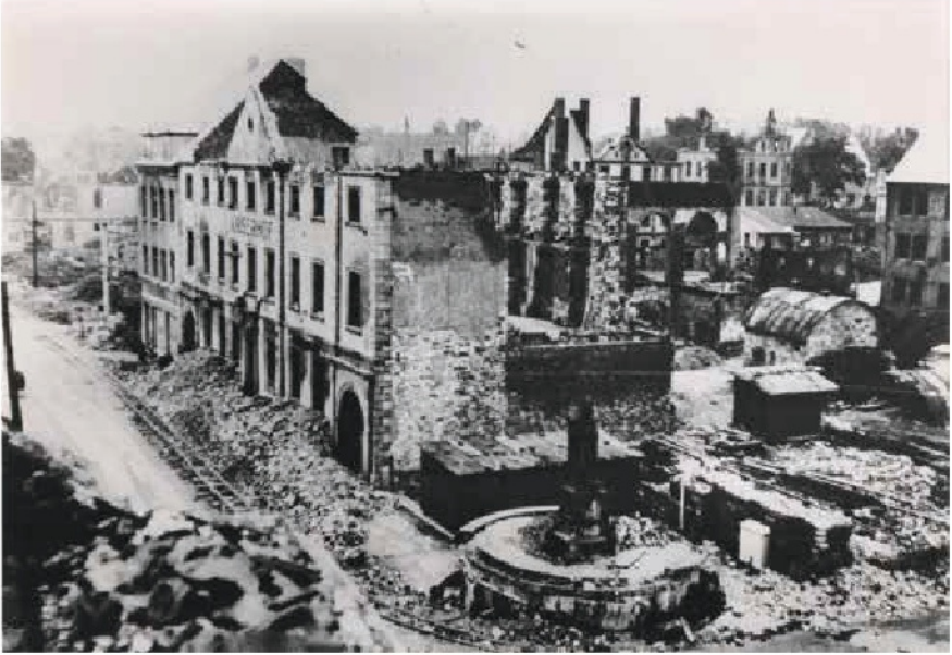
Das zerstörte Paderborn (Kamp / Ecke Liborstraße)
