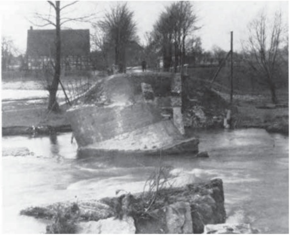
Eingestürzte Almebrücke von 1891 nach dem Hochwasser von 1909
