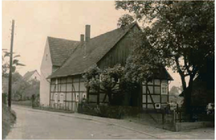
Germanenstraße 4 vor der Kernsanierung
