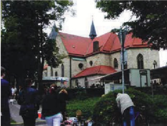
Blick auf die Erweiterungsbauten der Elsener Kirche von 1925/26: Querhaus und Chor
