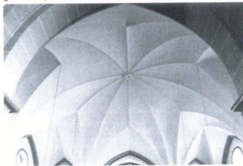
St.-Dionysius-Kirche, Gewölbe des Vorchores, 1993
