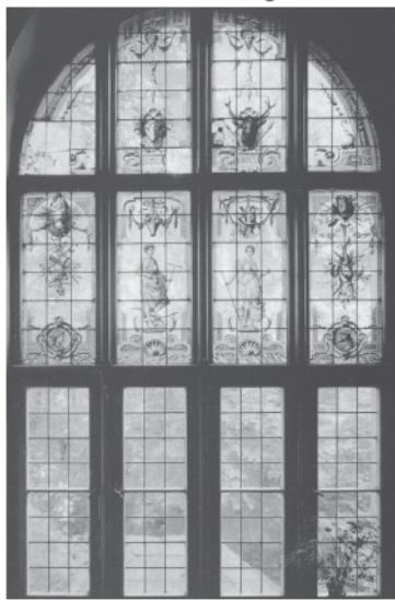
Fenster im Treppenhaus von Gut Ringelsbruch, Zustand 1979
