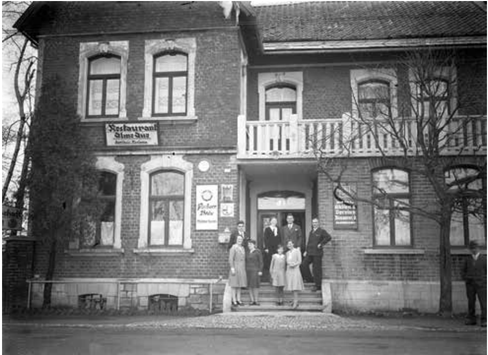
Die „Alme-Aue“ in den 1930er Jahren; vor dem Eingang hinten in der Mitte das Ehepaar Barthol und Klara Mertens, vermutlich im Kreis von Familienangehörigen. Links neben dem Eingang die Hinweisschilder auf die im Haus befindliche Poststelle und auf einen öffentlichen Fernsprecher. (Abb.: SKAP, Mertens)
