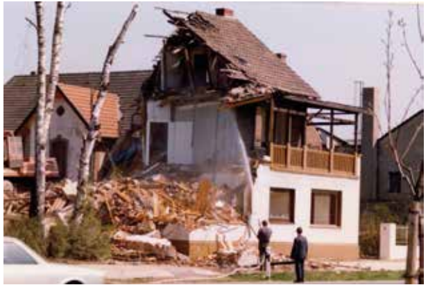
Das Ende: Abbruch am 23. April 1987 (Abb.: HVV, Segin)
