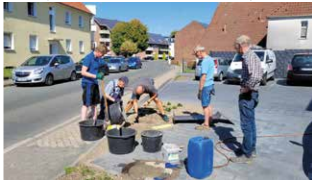
Fundamentarbeiten beim ehem. Standort des Autohauses Hißmann in der Urbanstraße (v.l. Franz Josef Wellen, Werner Hartmann, Klaus Schäfer, Bernd Lütkemeyer, Peter Hißmann)
