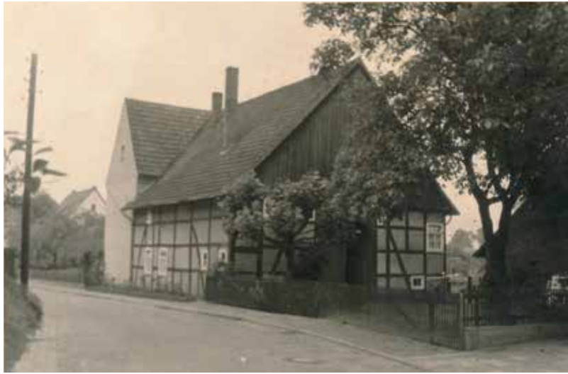
Germanenstraße 4 vor der Kernsanierung
