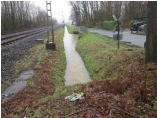
Die Jote am Elsener Bhf. Die Brückendurchlässe fassen kaum die Wassermassen.
