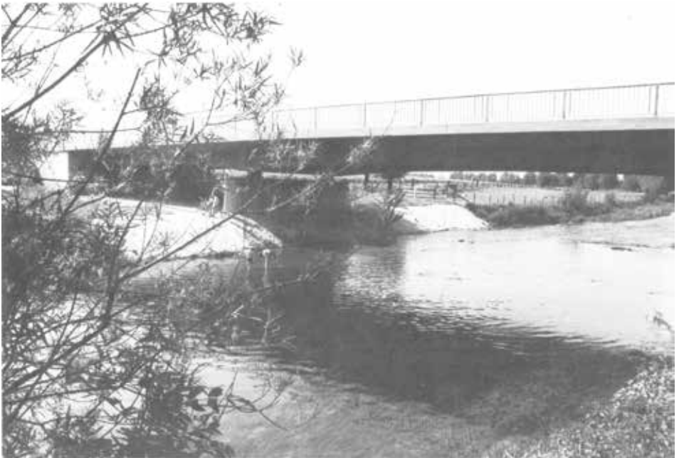
Die Almebrücke heute
