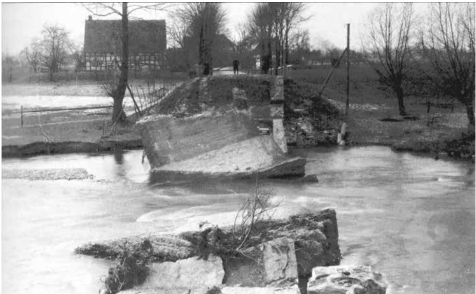
Trümmer der beim Hochwasser im Februar 1909 eingestürzten Almebrücke
