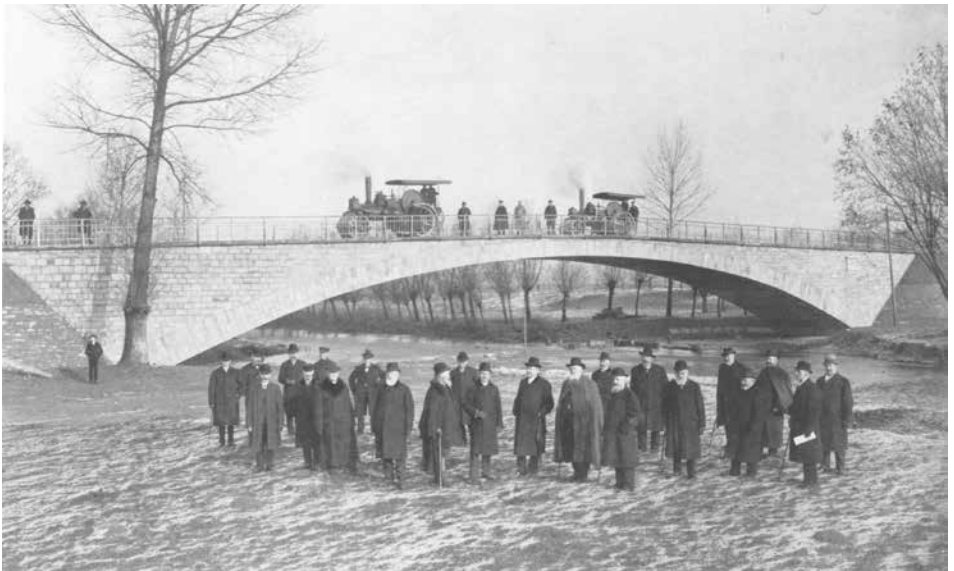
Die fertiggestellte neue Almebrücke bei der Prüfung der Tragfähigkeit im November 1910
